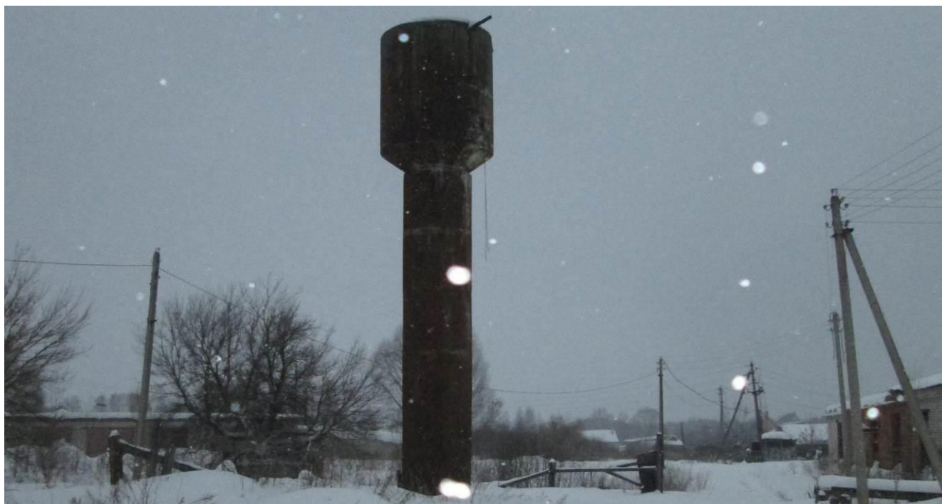
Рис. 1.61. Водонапорная башня по ул.Железнодорожная, 6д п.Алтышево
