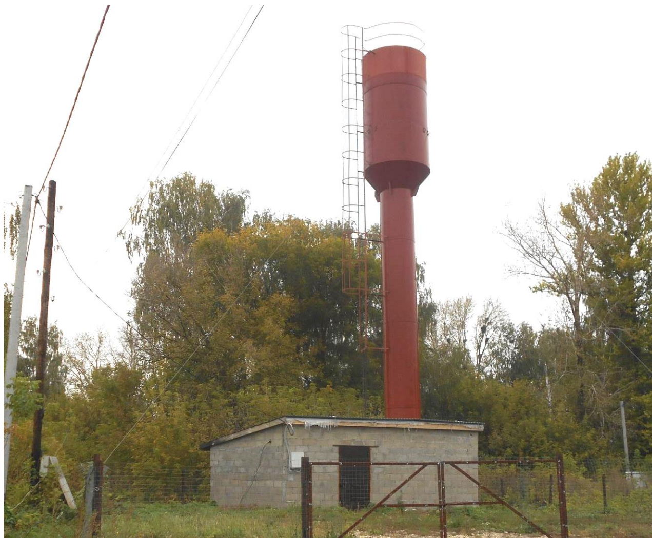
Рис. 1.42. Водонапорная башня п.Восход
