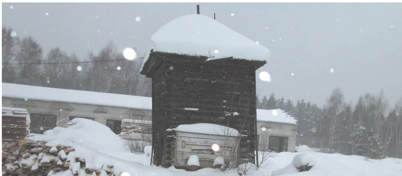
Рис. 1.58. Здание артезианской скважины №1 ул. Железнодорожная, 109 п.Алтышево
