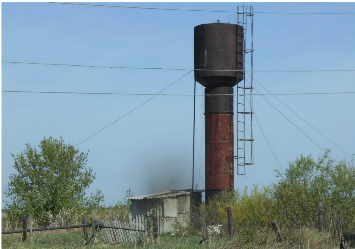
Рис. 1.52. Водонапорная башня с.Кувакино
