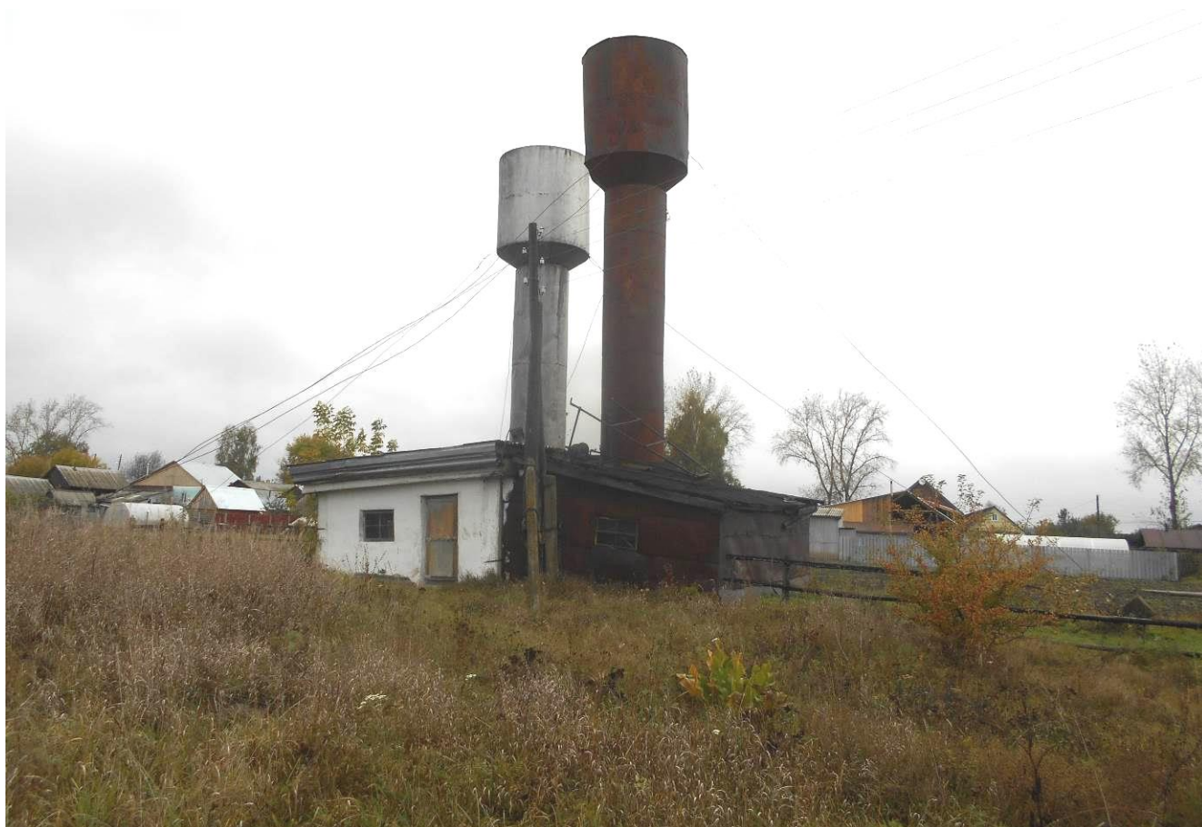
Рис. 1.55. Павильон и водонапорная башня скважины по ул.Горького с.Миренки
