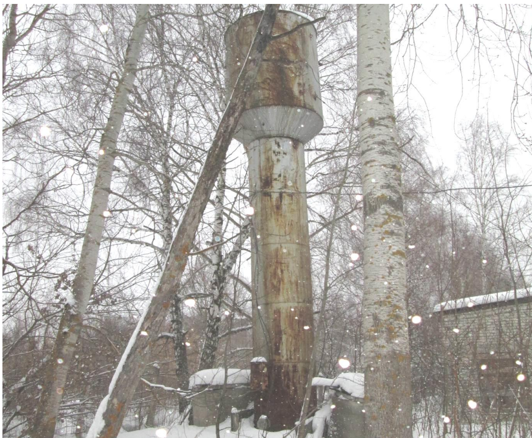
Рис. 1.59. Водонапорная башня по ул.Железнодорожная, 109 п.Алтышево
