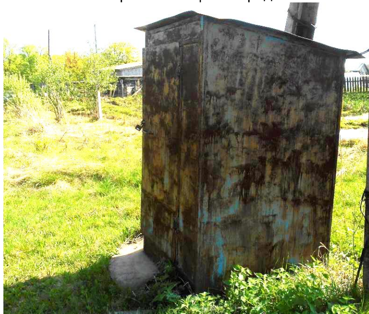
Рис. 1.33. Павильон скважины по ул. Ленина
