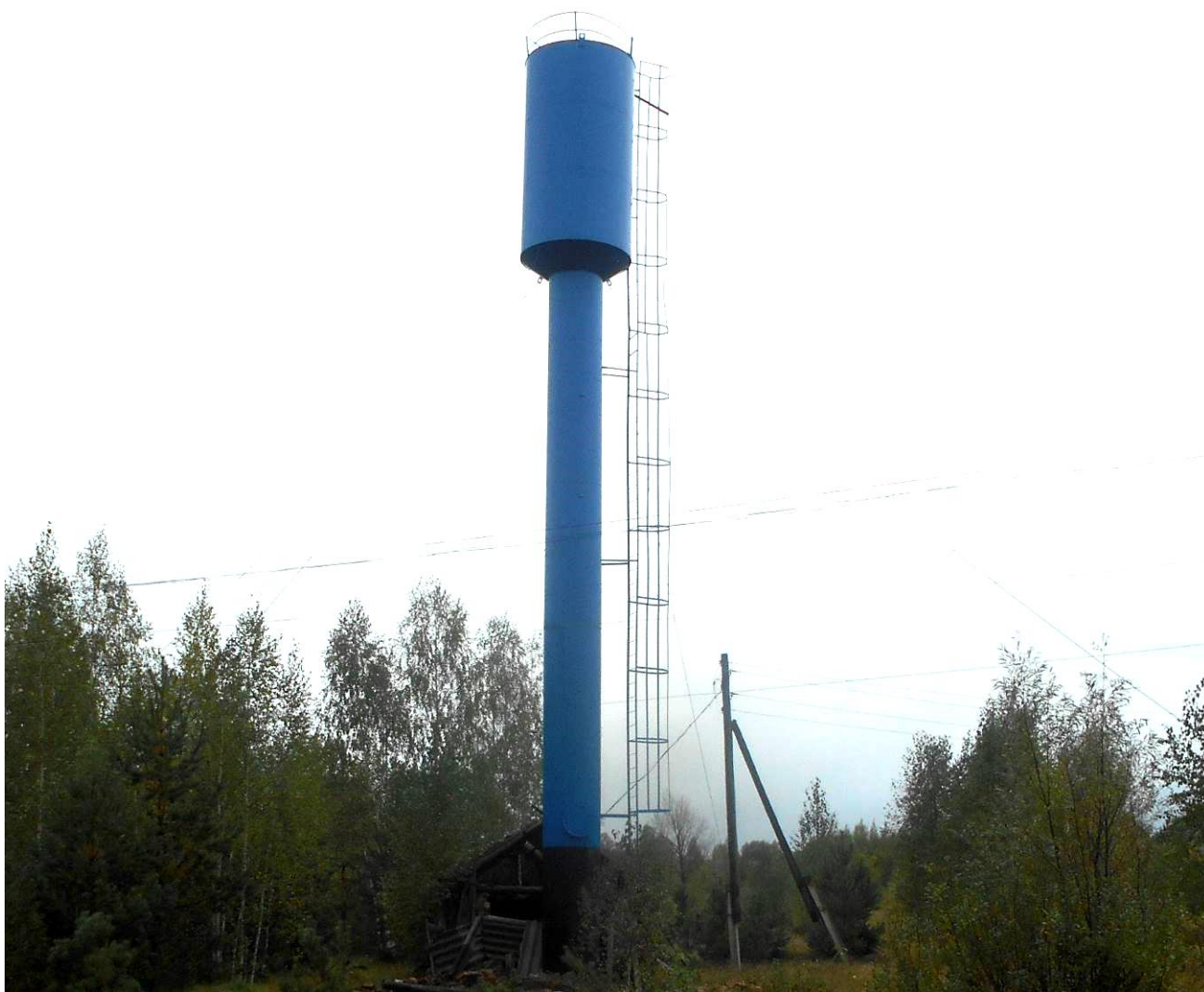
Рис. 1.40. Водонапорная башня по ул.Щорса с.Атрать
