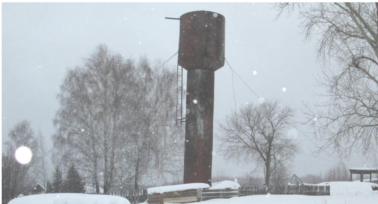
Рис. 1.62. Водонапорная башня по ул.Первомайская, 34а п.Алтышево
