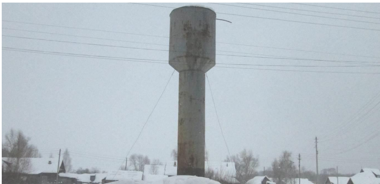
Рис. 1.64. Водонапорная башня по ул.Школьная, 6а п.Алтышево
