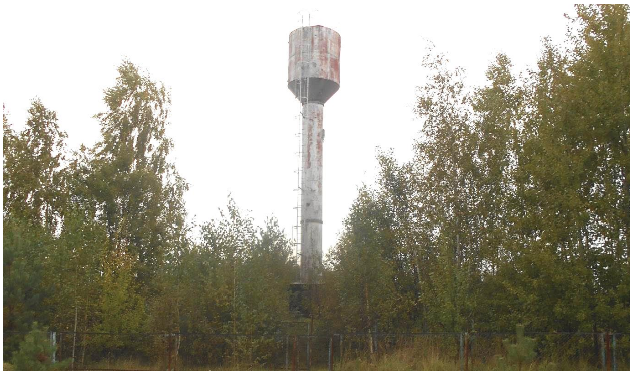
Рис. 1.39. Водонапорная башня ФСК с.Атрать
