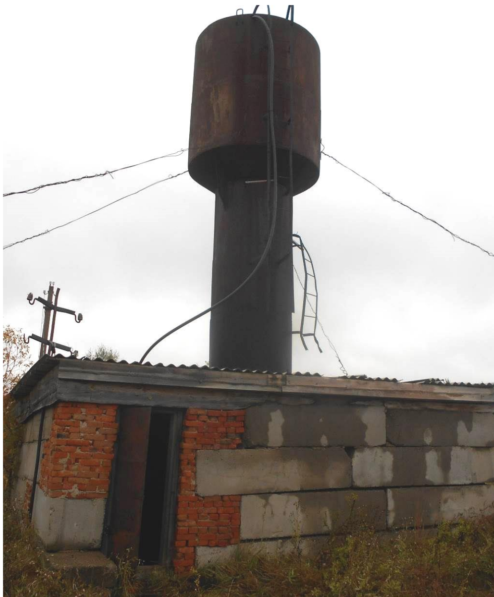
Рис. 1.57. Водонапорная башня с.Явлеи
