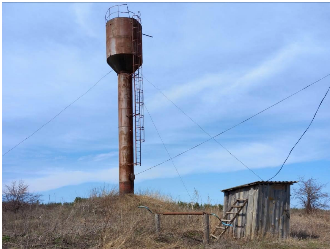
Рис. 1.45. Водонапорная башня и павильон по ул.Кирова с.Иваньково-Ленино
