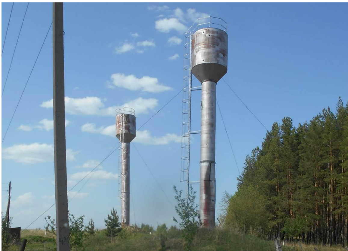
Рис. 1.34. Водонапорные башни по ул.Болонина с.Алтышево
