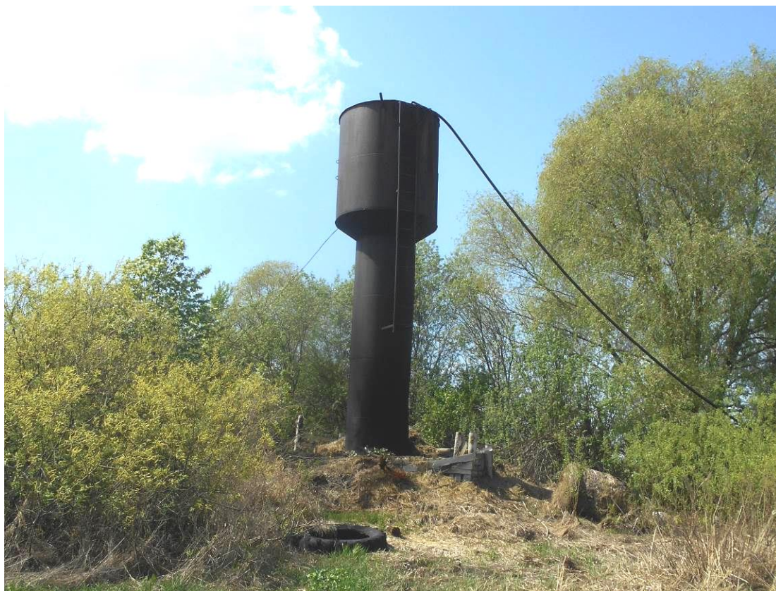
Рис. 1.36. Водонапорная башня п.Анютино
