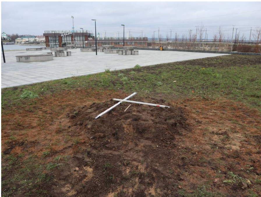
Рис. 10. Шурф № 1. После рекультивации. Вид с юга.
