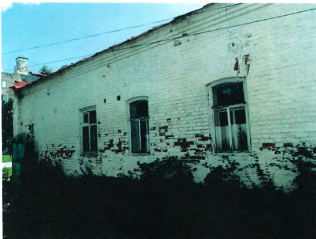
Фото № 2. Боковой фасад.
