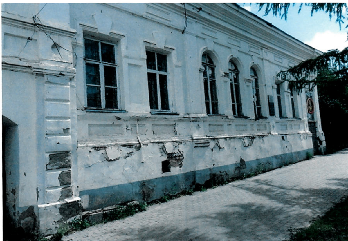
Фото № 2. Фрагмент южной части здания.
