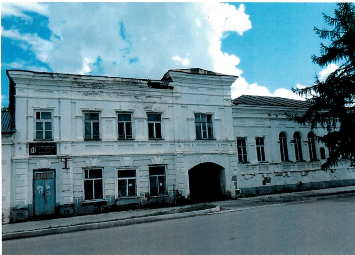
Фото № 1. Общий вид объекта культурного наследия.
