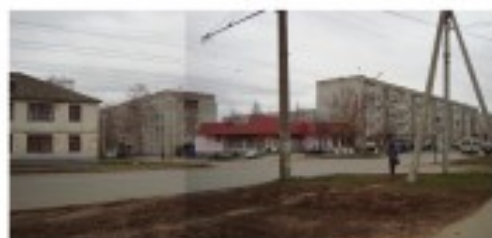
Существующая застройка на углу ул.Багмачникова и Алавердина
