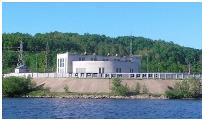
Береговая насосная станция
