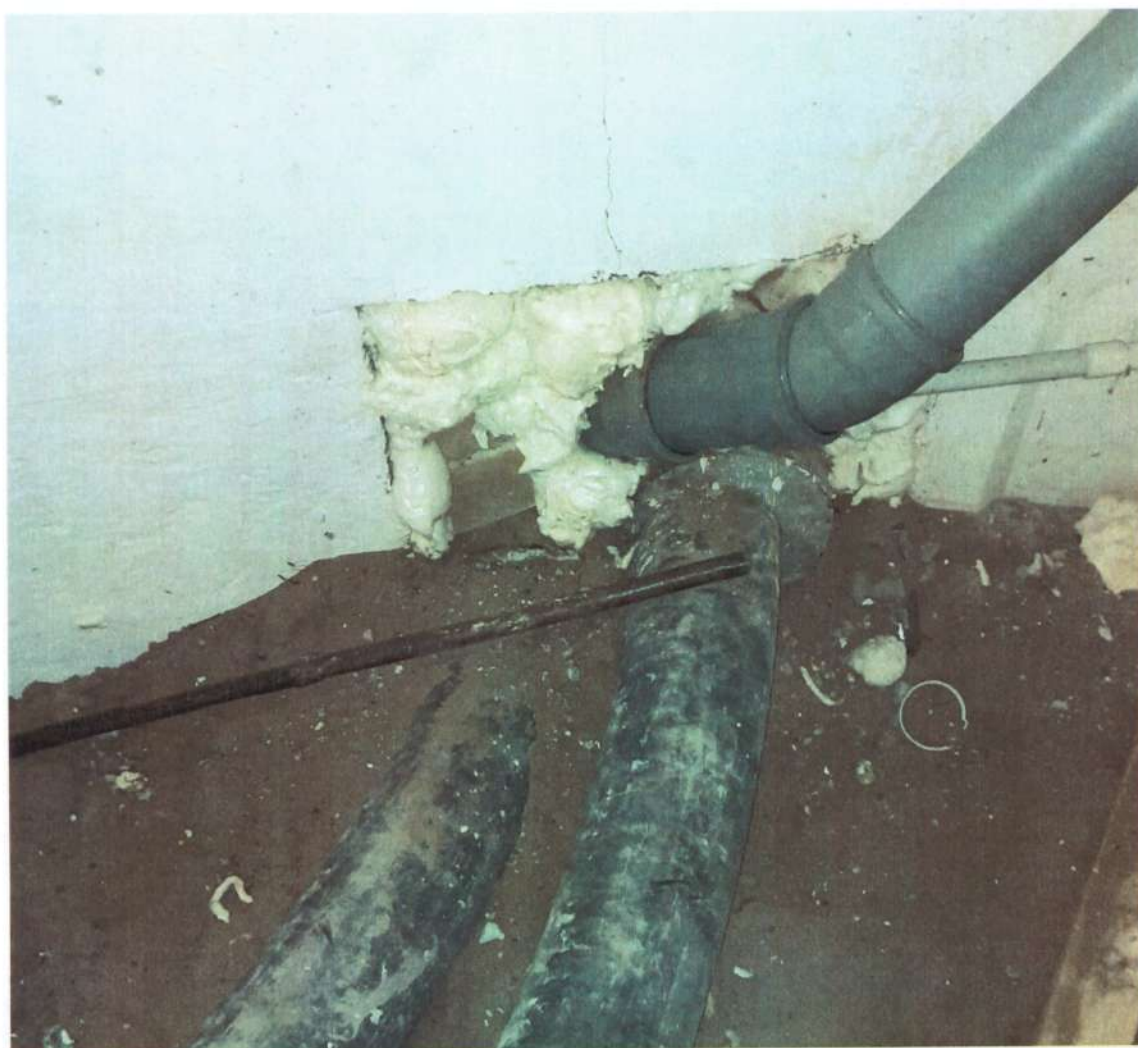
Герметизация ввода в здание по ул. Биржевая, 76
