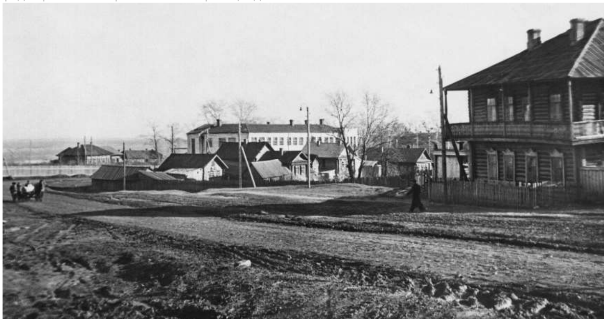
Рис. 1.4.3. Школа № 2 на ул. Чувашской, г. Чебоксары, 1934 г.
