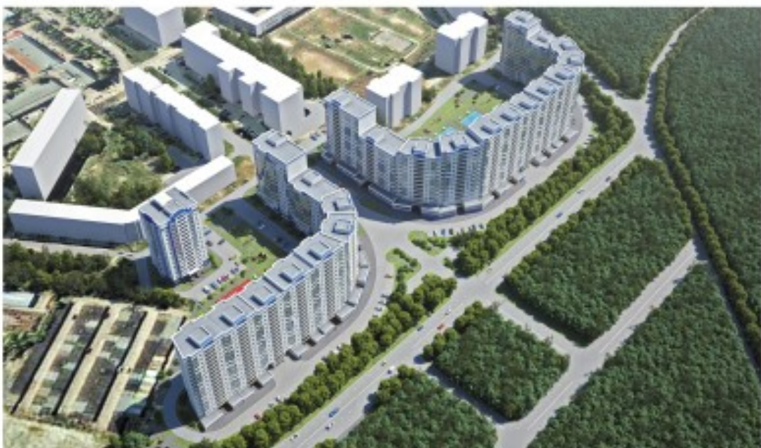
Вид с высоты птичьего полета с северной стороны
