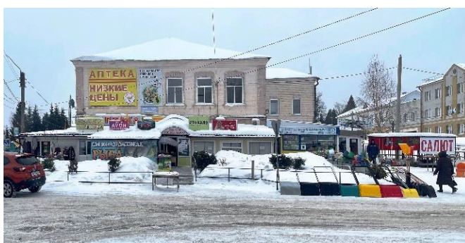
Боковой (северный) фасад
