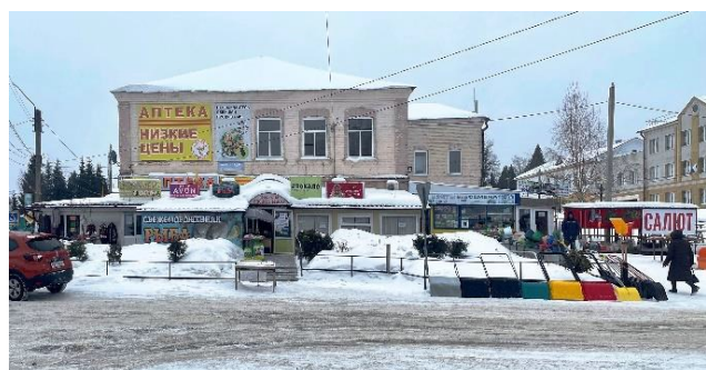
Боковой (северный) фасад
