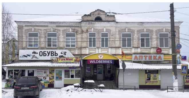
Главный (восточный) фасад
