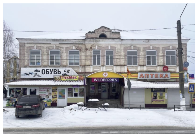
Главный (восточный) фасад
