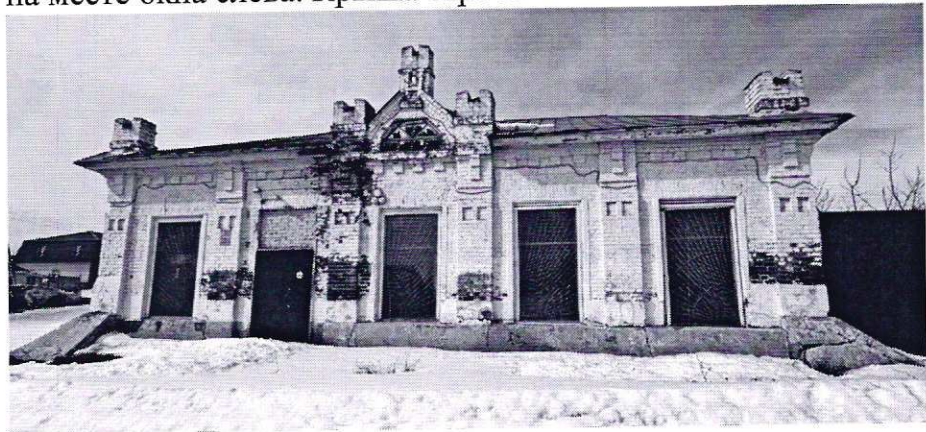
Вид на восточный фасад
