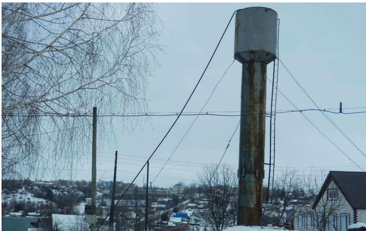
Рис. 1.20. Водонапорная башня №6 по ул. Советская, 10 с. Ишлеи
