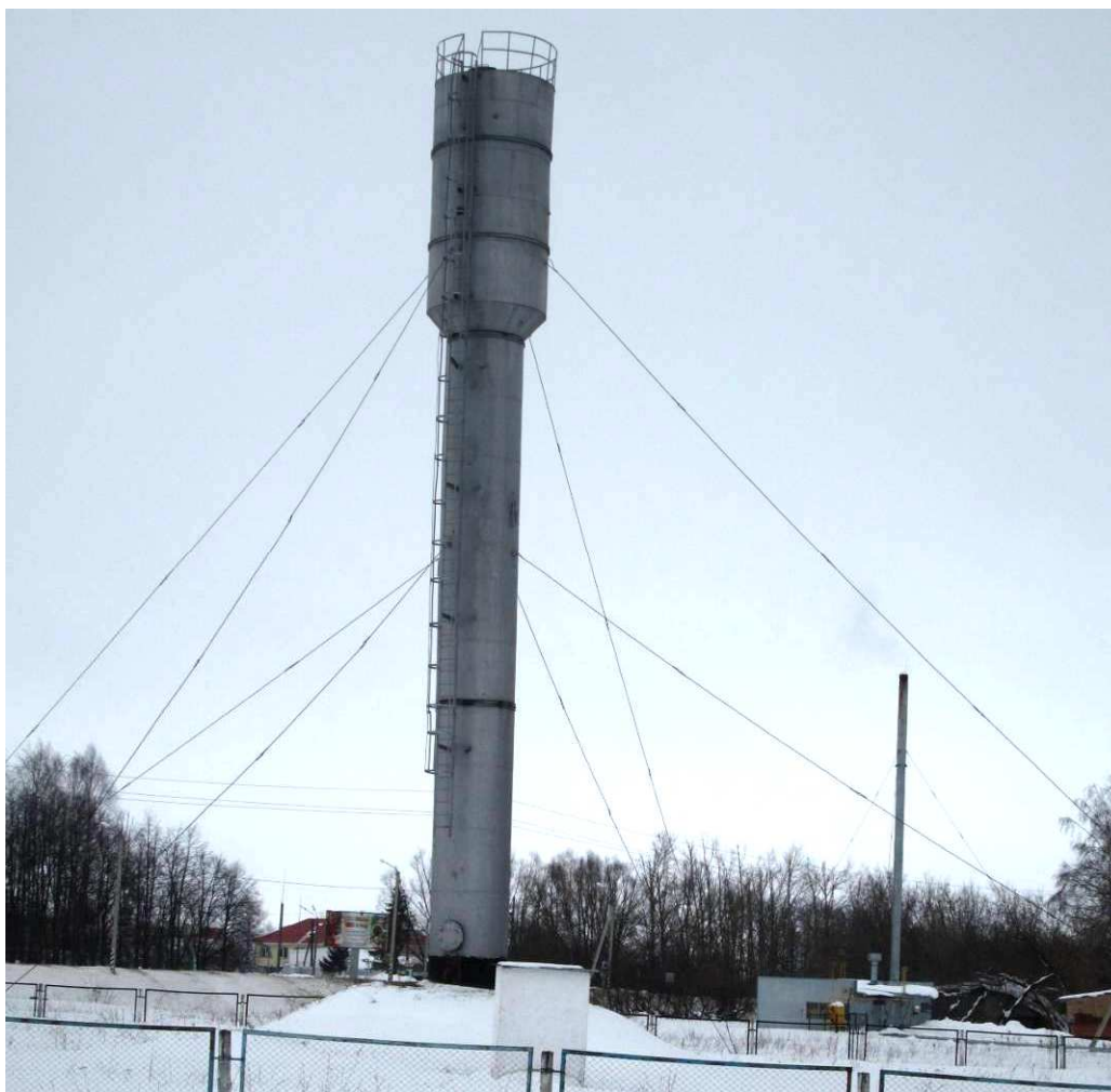
Рис. 1.17. Водонапорная башня №3 по ул. Советская, 84 с. Ишлеи
