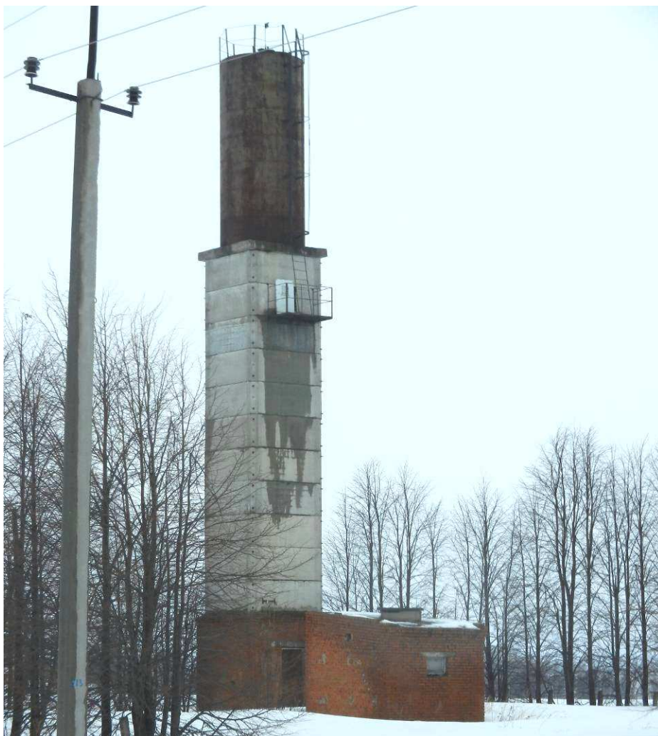
Рис. 1.25. Павильон и водонапорная башня от артезианской скважины д. Кораки-Чурачки
