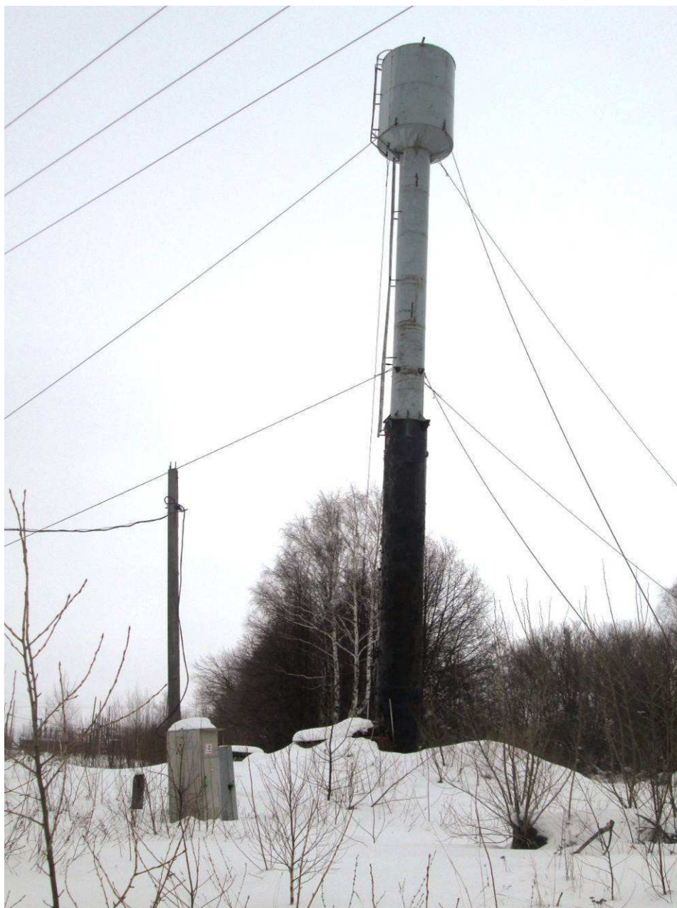
Рис. 1.18. Водонапорная башня №4 восточная окраина с. Ишлеи
