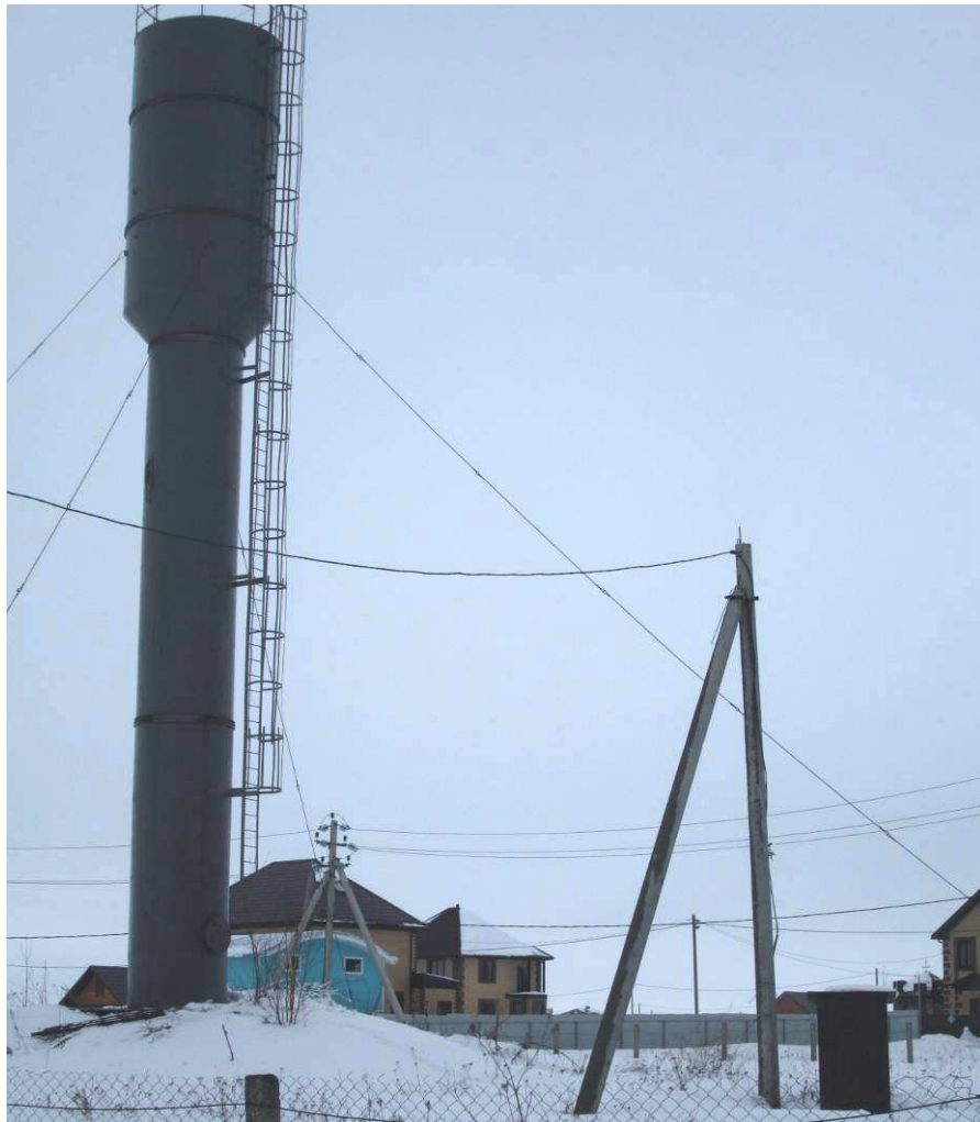
Рис. 1.21. Водонапорная башня №7 по ул. Полевая с. Ишлеи
