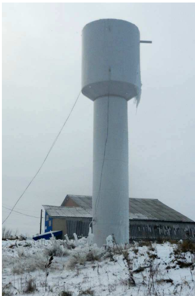
Рис. 1.12. Водонапорная башня №3 д. Митрофанкасы
