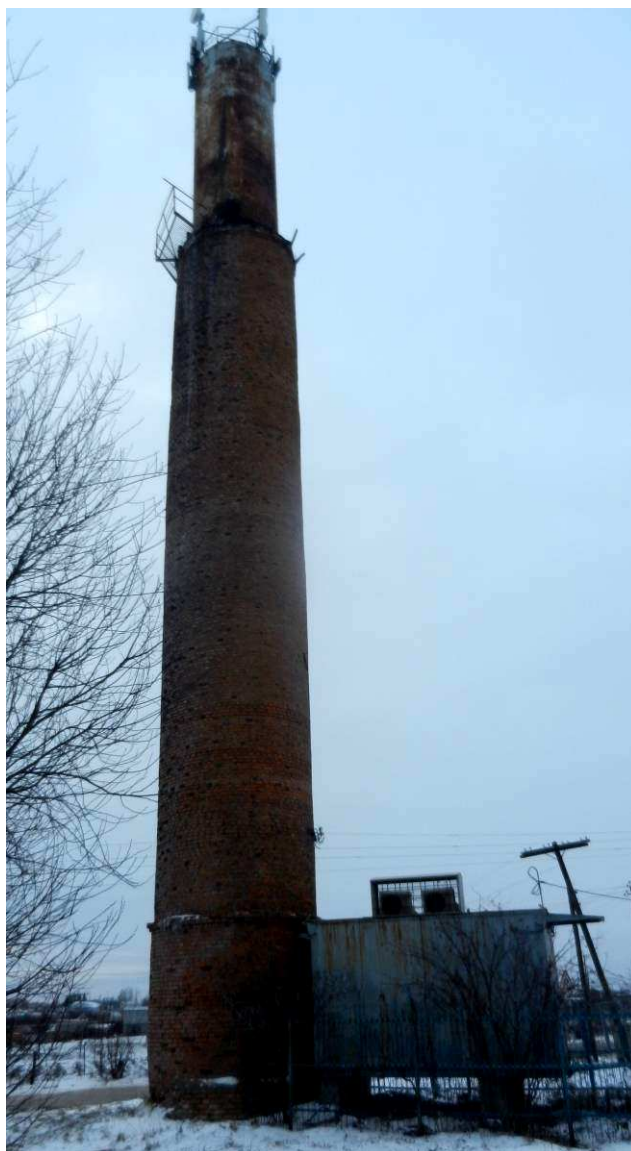
Рис. 1.9. Водонапорная башня №1 д. Б.Катраси
