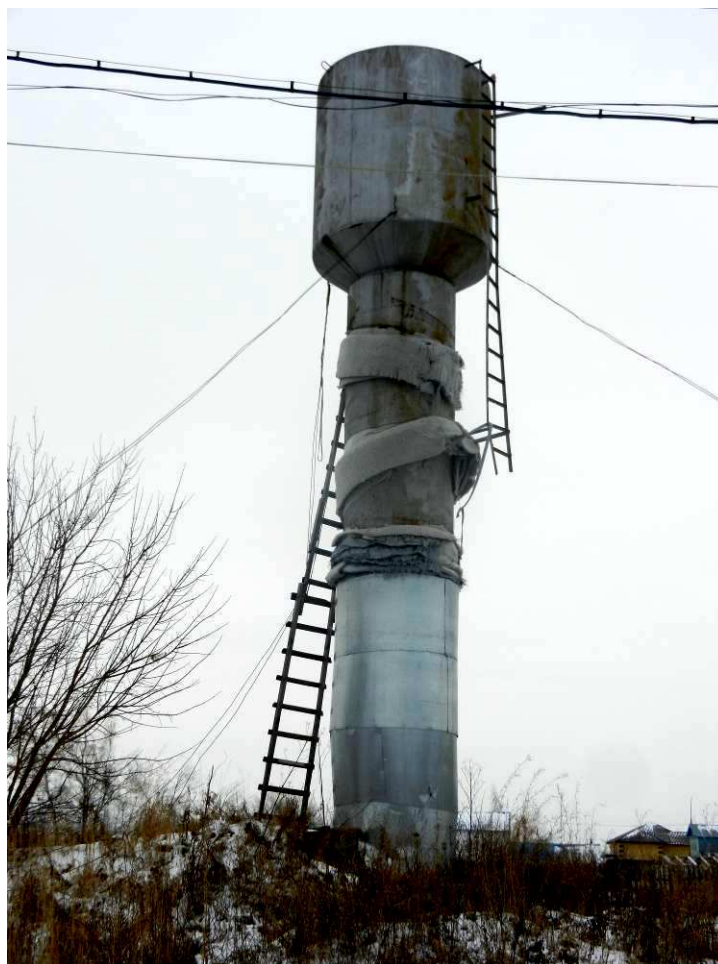
Рис. 1.18. Водонапорная башня №6 д. Василькасы
