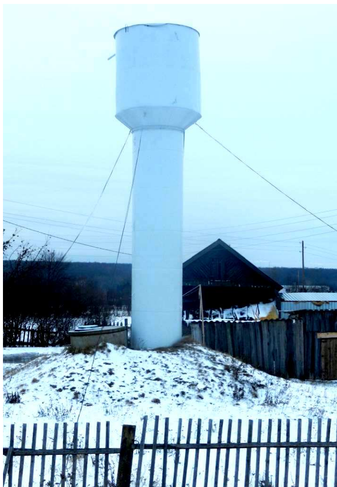
Рис. 1.14. Водонапорная башня №4 д. Малое Янгильдино
