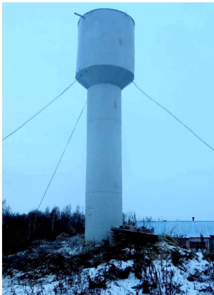
Рис. 1.20. Водонапорная башня №7 д. Сархорн
