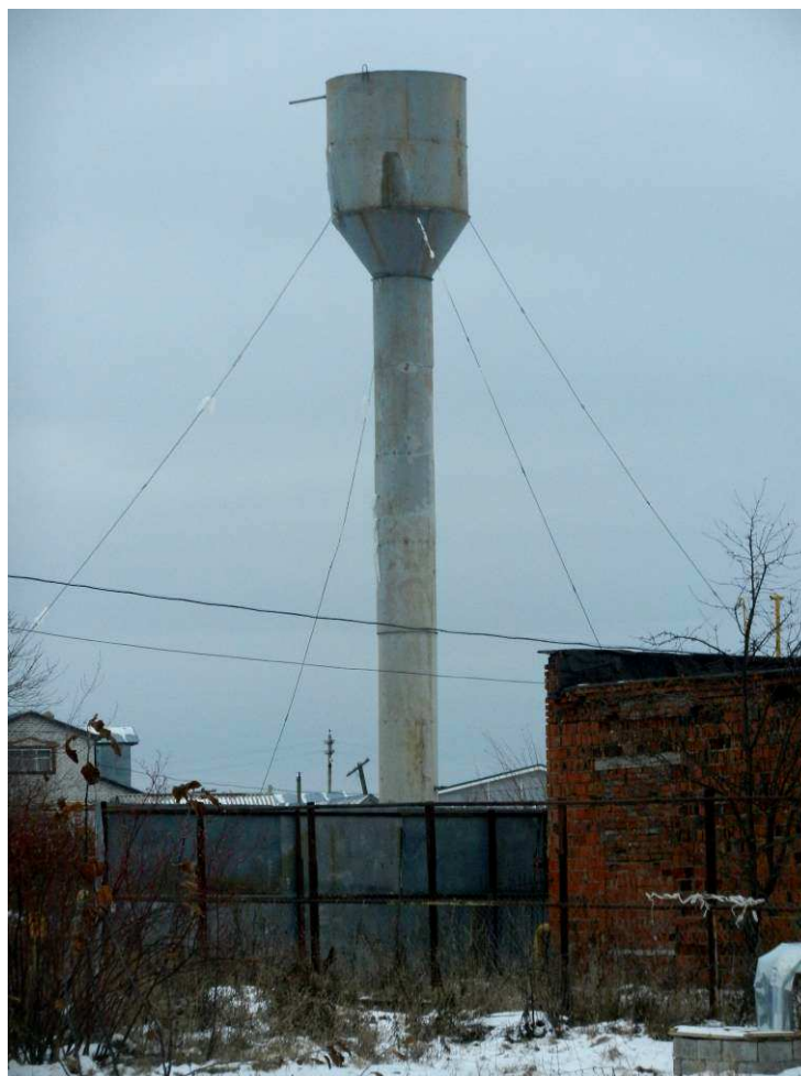
Рис. 1.10. Водонапорная башня №2 д. Б.Катраси
