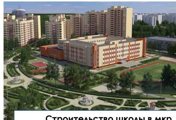
Строительство школы в мкр. «Университетский-2» г. Чебоксары
