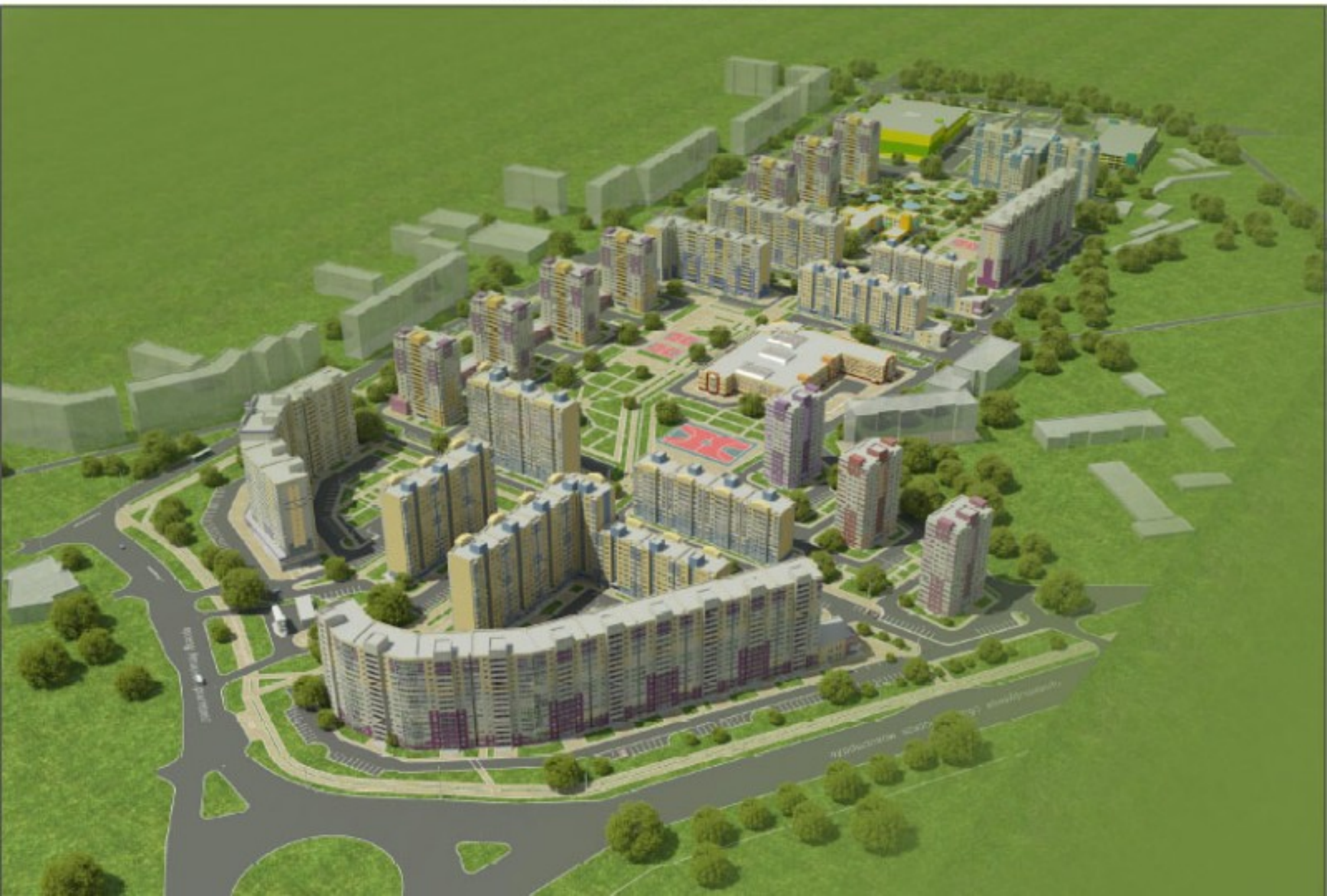
Вид с северо-восточной стороны
