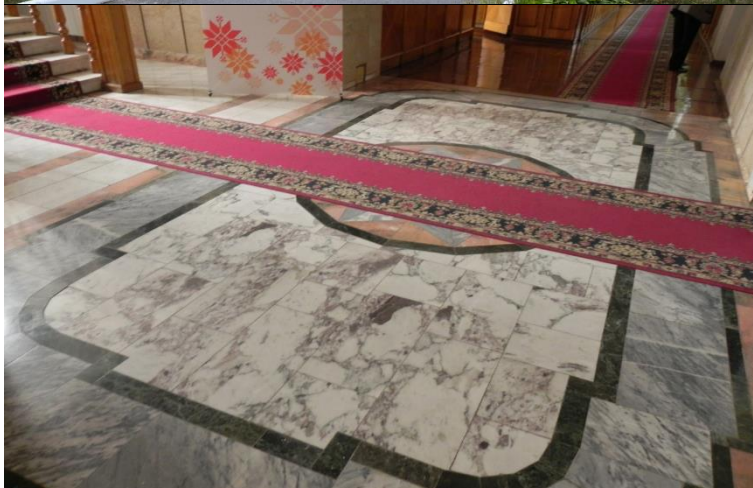
Внешняя видовая точка 16 Вид на напольное покрытие главного холла объекта культурного наследия «Здание Чувашского государственного университета им. И.Н. Ульянова». 10.09.2023 г.
