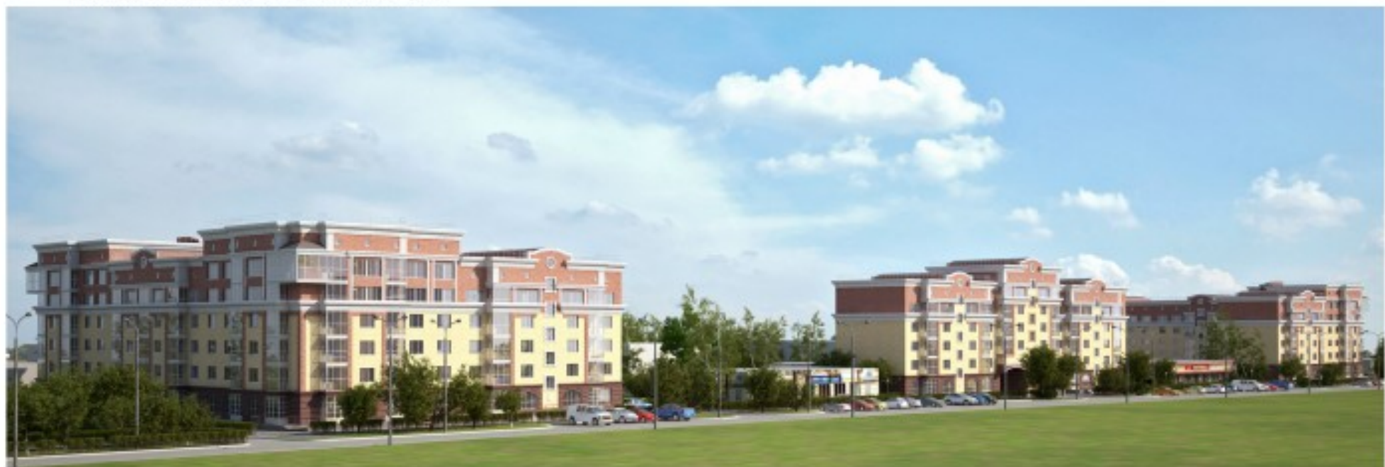
Существующая застройка на углу ул.Кремлевского и Ашмарина
