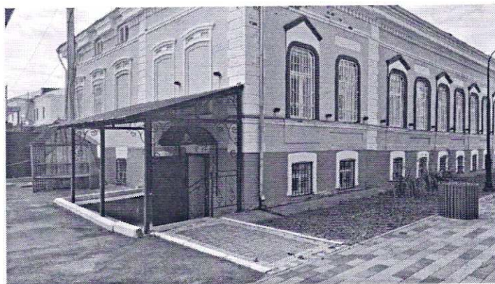
Фрагменты здания (фото 2021 г.)
