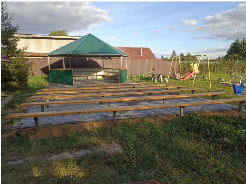
Устройство беседки в д. Первые Тойси Цивильского муниципального округа
