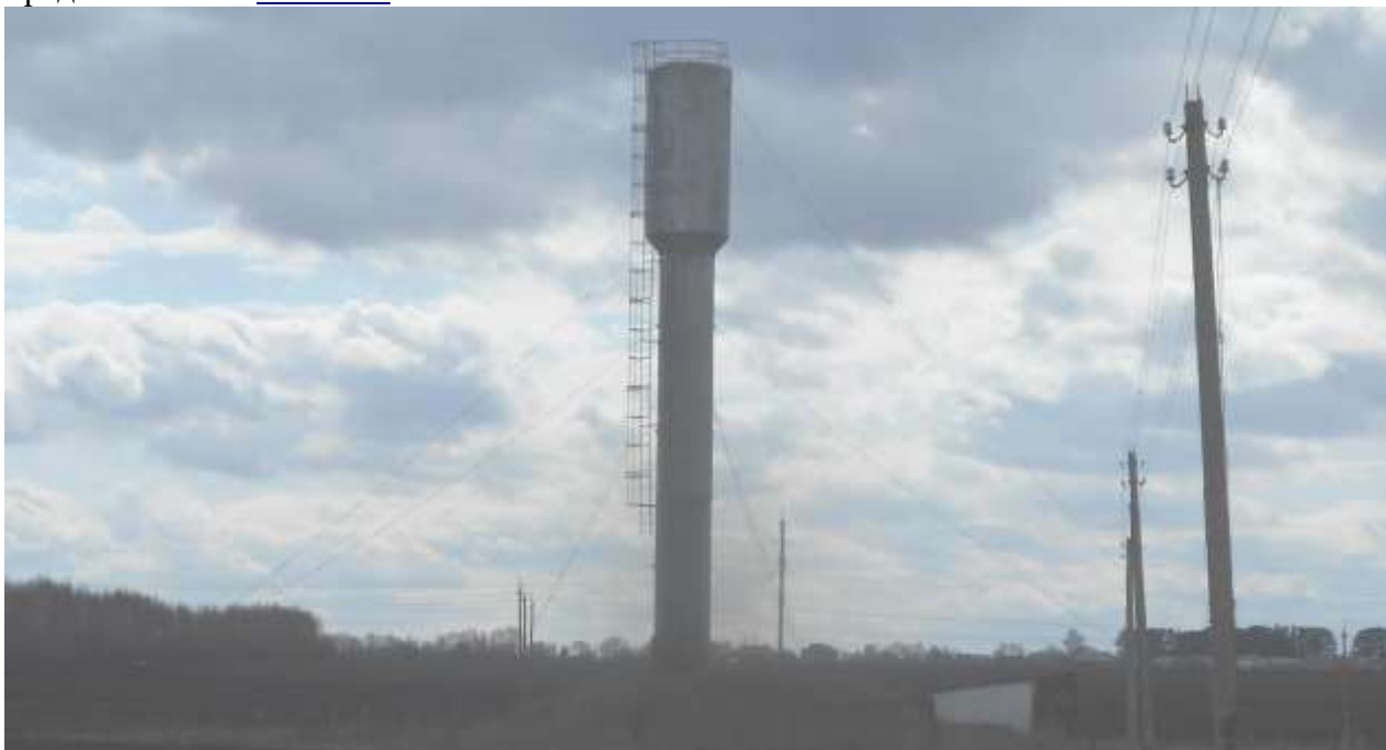
Рис. 1.15. Водонапорная башня ул. Мира с. Янтиково
