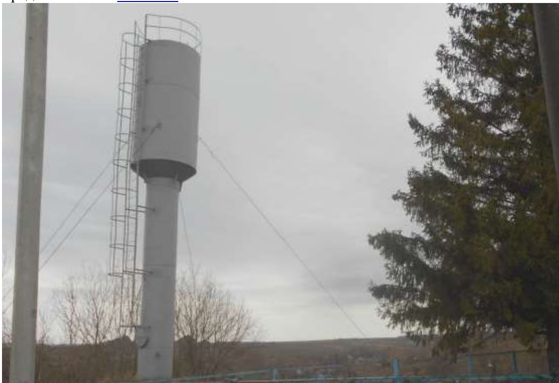
Рис. 1.13. Водонапорная башня ул. Нагорная с. Янтиково
