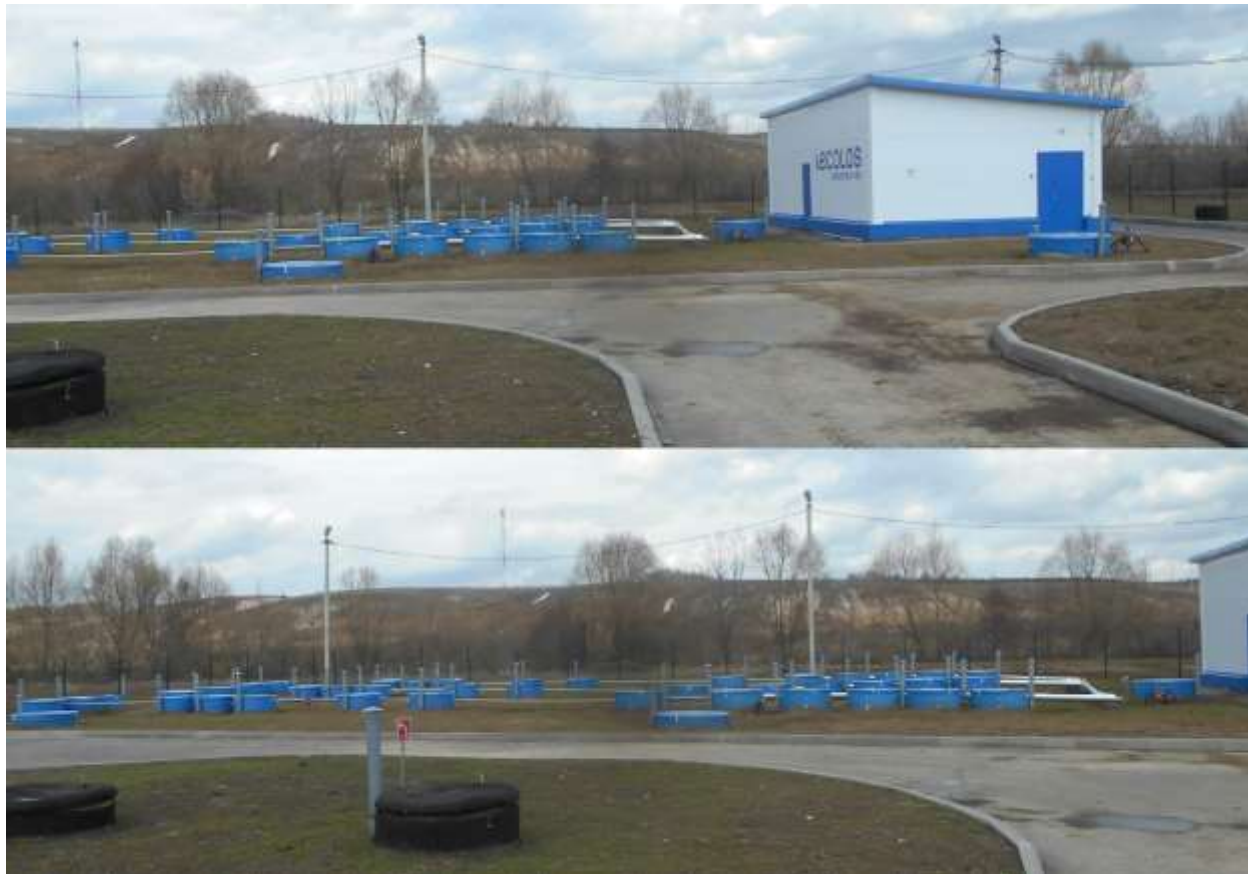
Рис. 1.1. Новая станция биологической очистки сточных вод с. Янтиково
