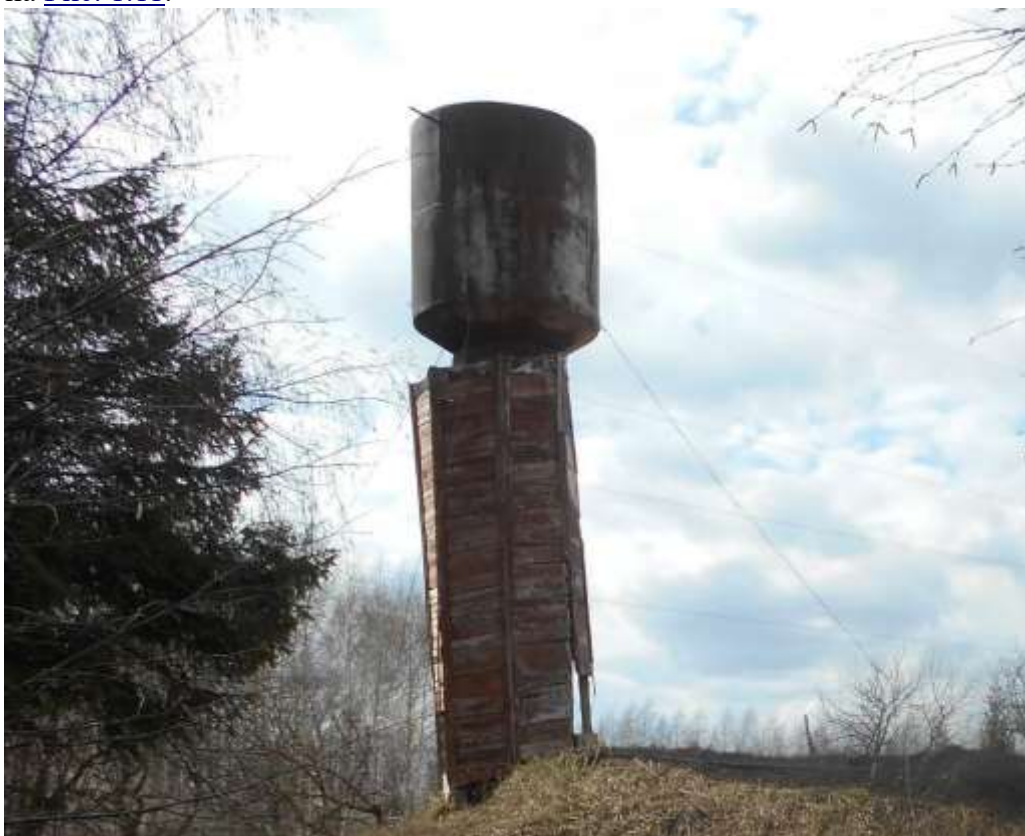
Рис. 1.11. Водонапорная башня пр. Ленина с. Янтиково
