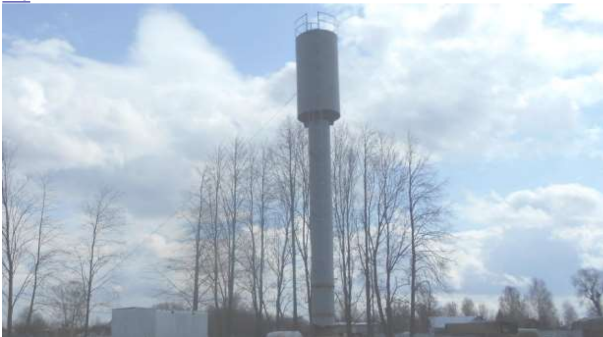
Рис. 1.23. Водонапорная башня д. Подлесное
