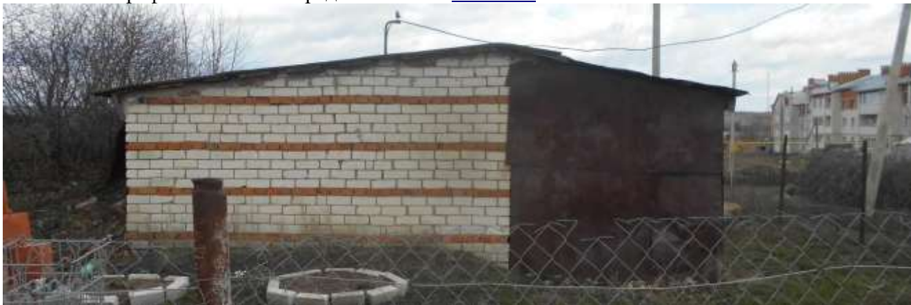
Рис. 1.14. Павильон артезианской скважины по ул. Мира с. Янтиково
