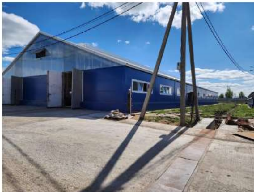
Илл. 17. Точка фотофиксации 4. Вид на обследованный земельный участок с севера.
