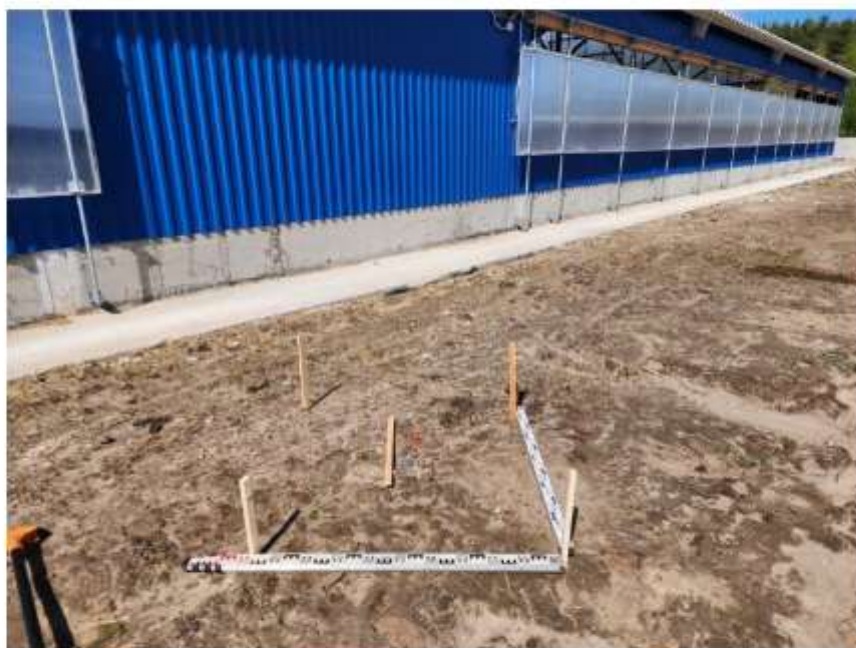
Ілл. 36. Шурф 2 перед началом работ. Вид с юга.
