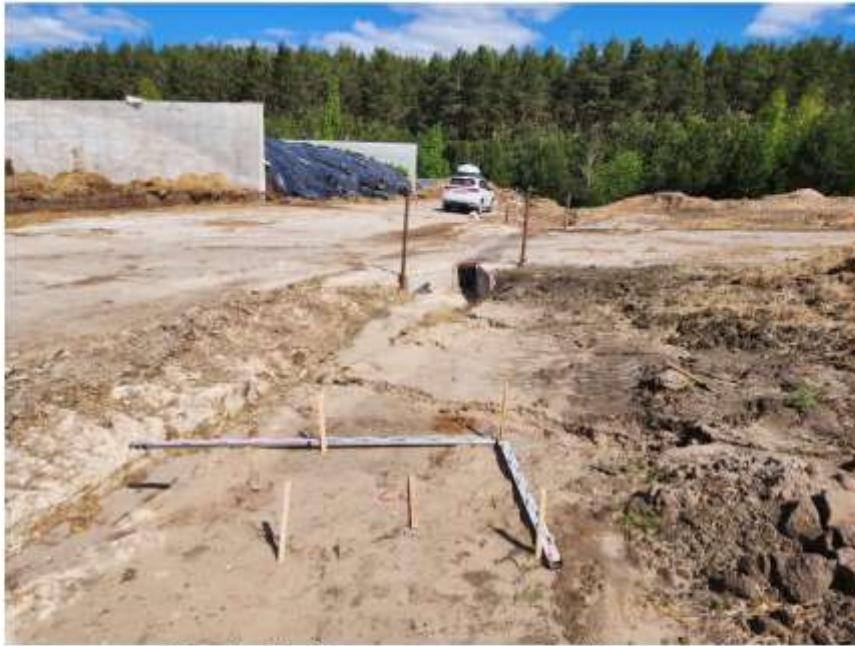
Илл. 31. Шурф 1 перед началом работ. Вид с юга.
