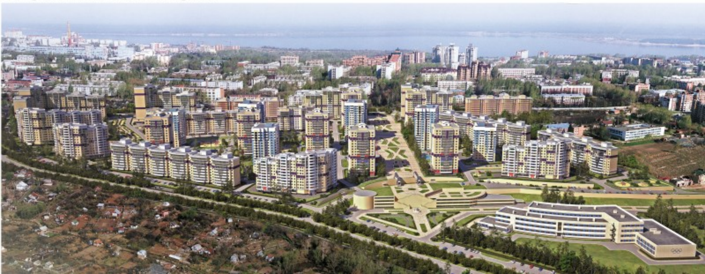
Панорамный вид с южной стороны
