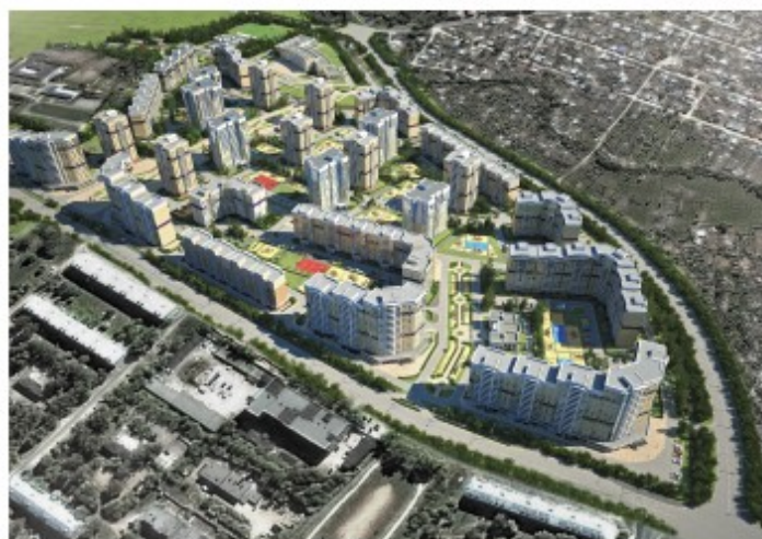
Панорамный вид с северо-восточной стороны
