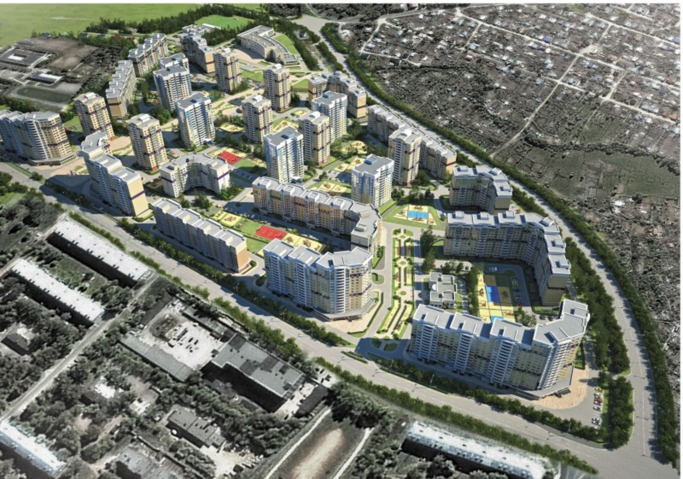
Панорамный вид с северо-восточной стороны
