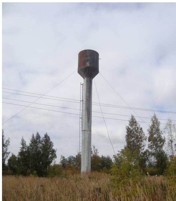
Рис. 1.13. Водонапорная башня №1 от артезианской скважины с. Абашево
