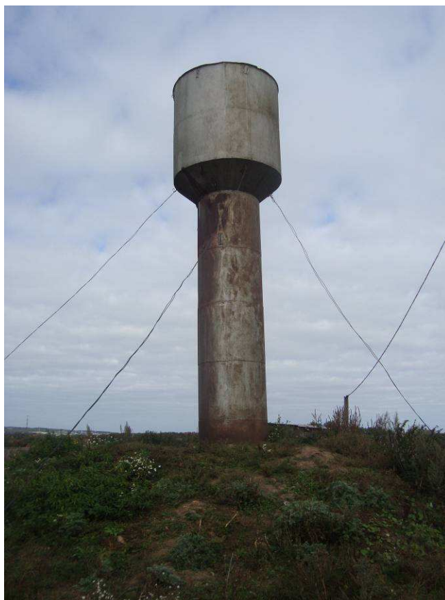
Рис. 1.19. Водонапорная башня от артезианской скважины д. Завражное
