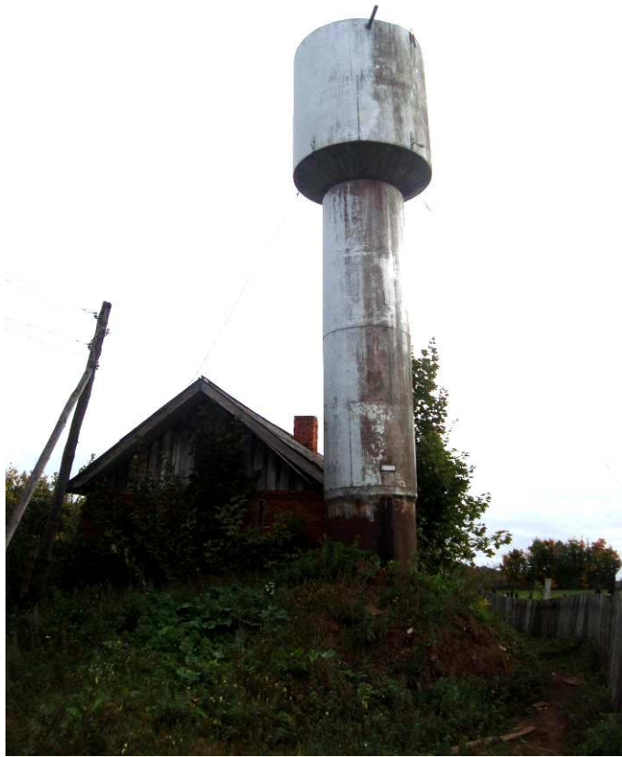
Рис. 1.17. Водонапорная башня от артезианской скважины №4 с. Абашево
