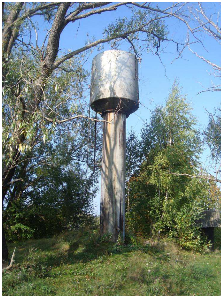
Рис. 1.31. Водонапорная башня от артезианской скважины д. Эзеккасы
