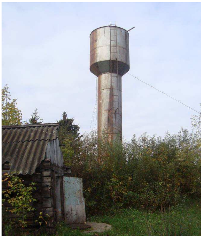
Рис. 1.15. Водонапорная башня от артезианской скважины №3 с. Абашево
