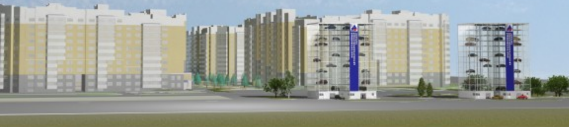
Многоуровневый автоматизированный паркинг в микрорайоне "Университетский-2"
